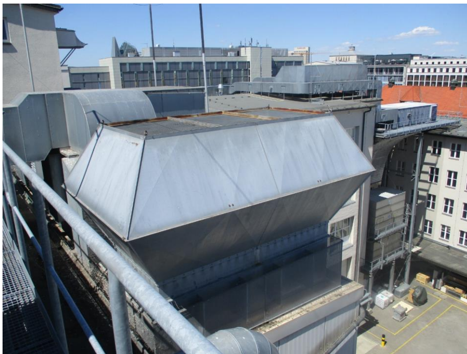
圖 28、處理後廢氣排放管道
