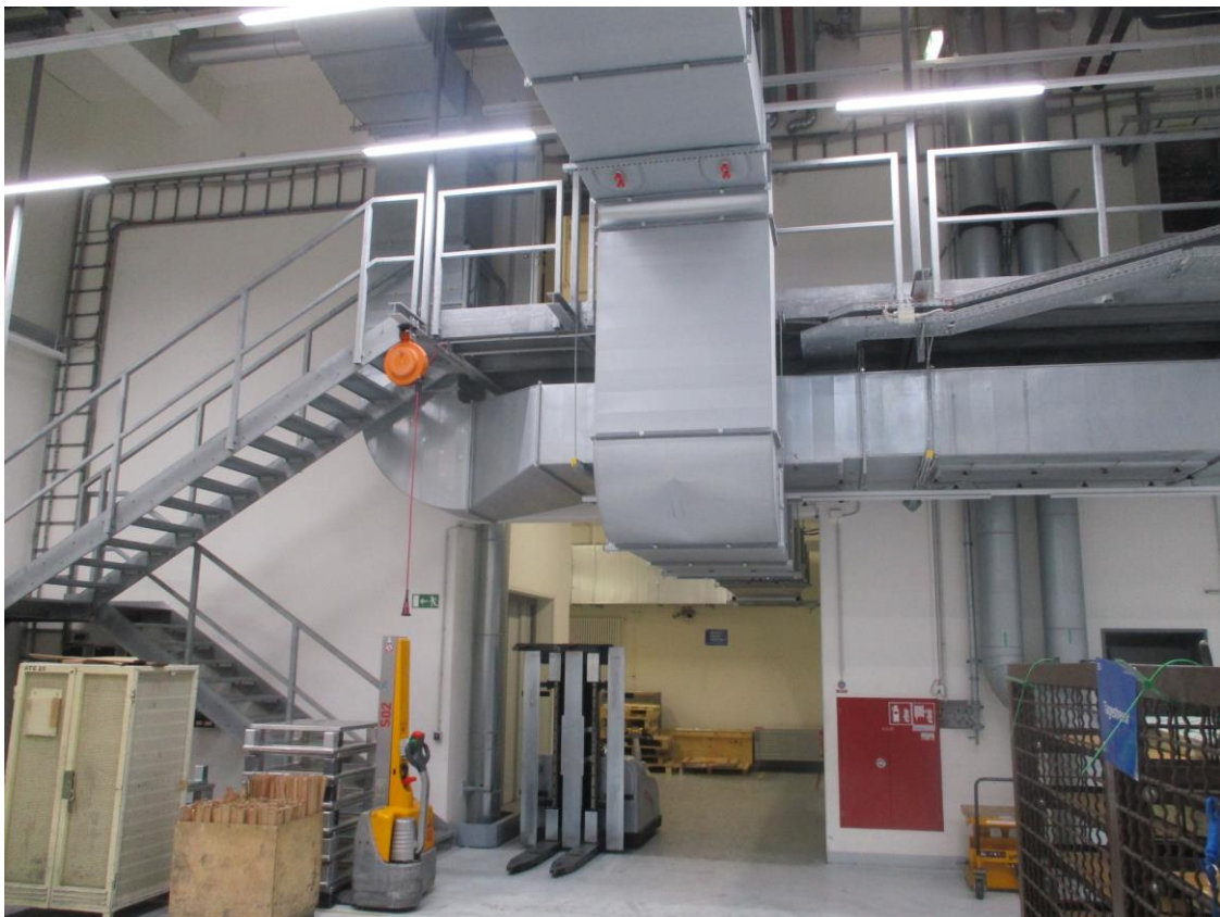
圖 26、新廠房作業區實景
