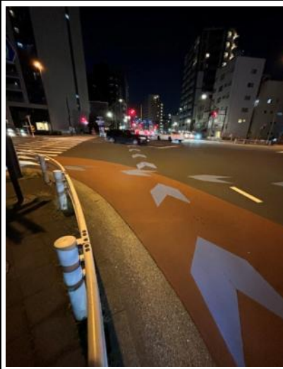
藏前，路口自行車標線支延伸，直行自行車與轉向汽車衝突可能
