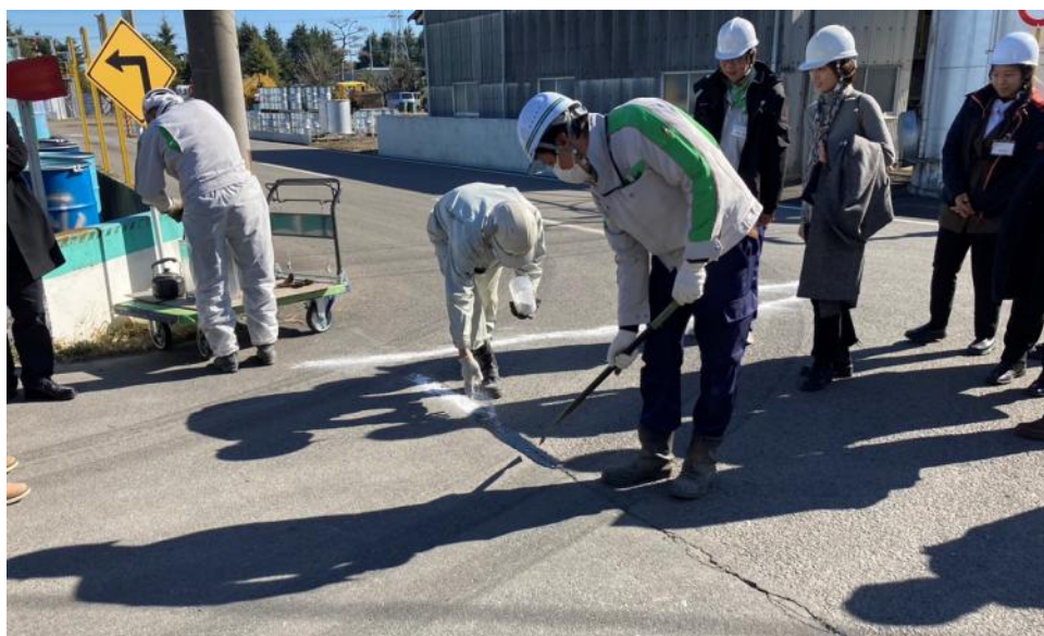
圖 2.54 裂縫修補 Crack Seal NX 示範(Nichireki 協助攝影)
