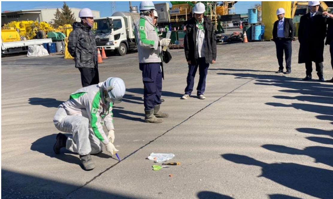
圖 2.53 裂縫修補 Coal Cut K 示範(Nichireki 協助攝影)
