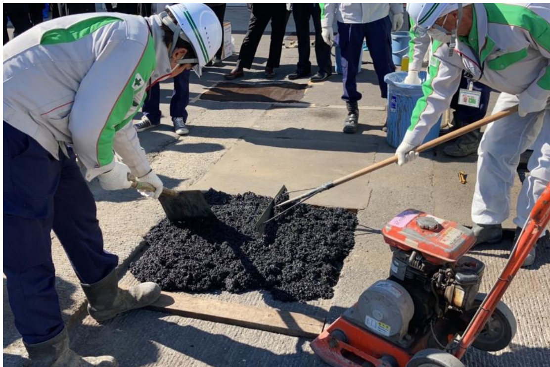
圖 2.51 坑洞修補示範現場操作(Nichireki 協助攝影)
