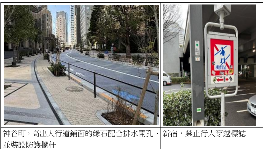
圖 2.35 行人阻隔保護-在車流大且車速快的道路(現場攝影)
