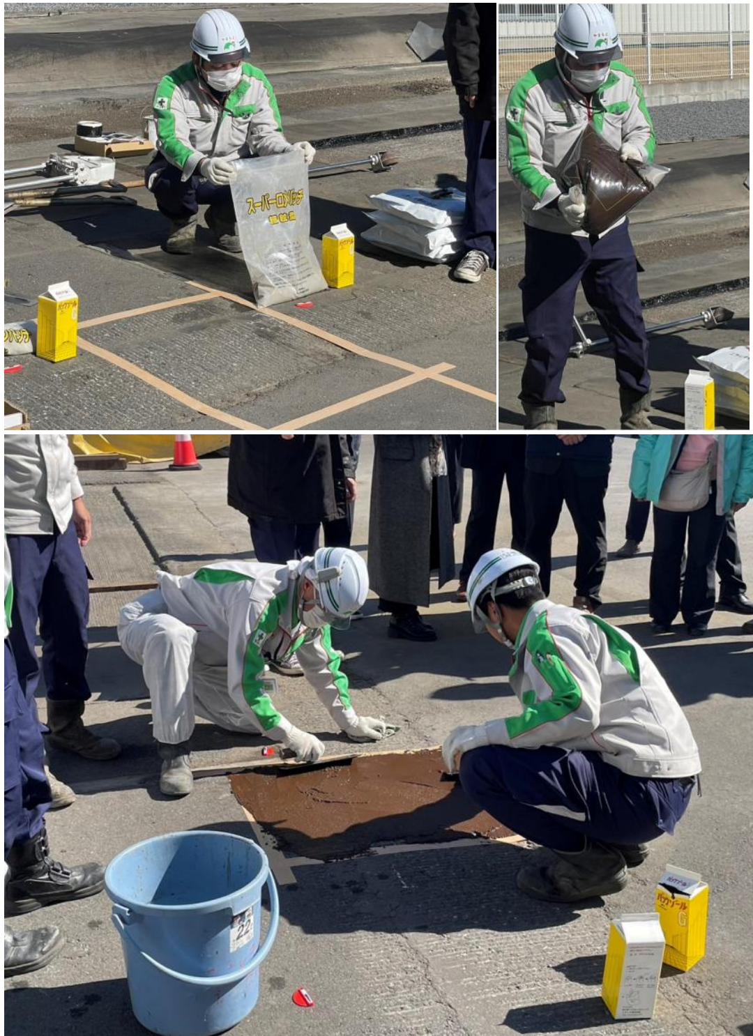
圖 2.52 高低差修補材料示範現場操作(Nichireki 協助攝影)
