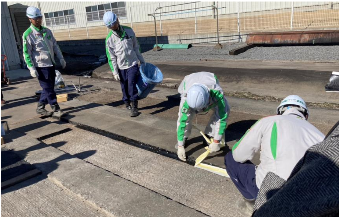
圖 2.55 端部成形止水帶材料鋪設示範(Nichireki 協助攝影)
