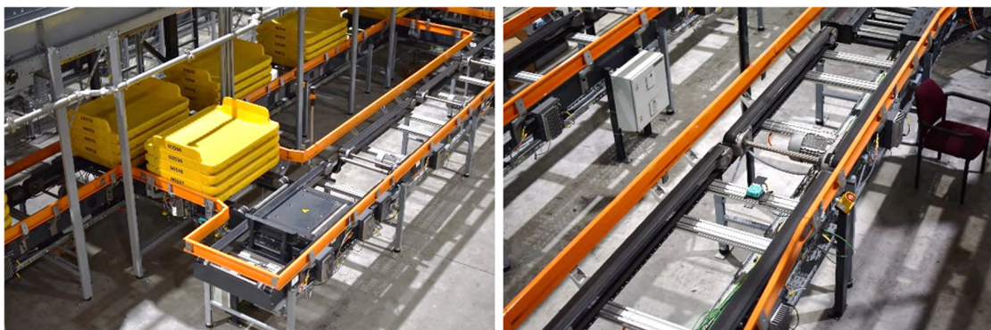
圖 15 ICS 交叉傳輸設備(左圖)及 RFID 讀取器(右圖中央)
