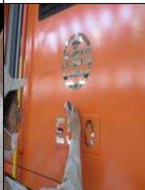
圖 11-23:駕駛室結構漆膜測量點 12
