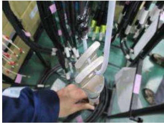
圖29:端子空隙處塗上矽膠
