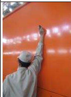
圖 11-9:機械室側 牆總成漆膜測量點 5
