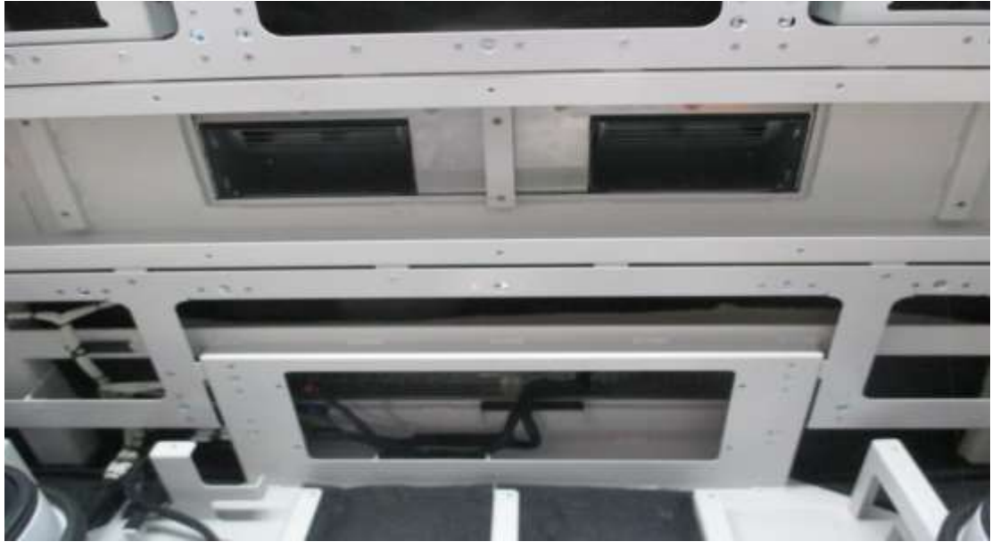
圖 15:檢視 RA 回風口與 SA 出風口沒有漏水
