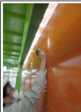
圖 11-1:機械室側 牆總成漆膜測量點 1
