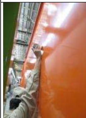
圖 11-5:機械室側 牆總成漆膜測量點 3
