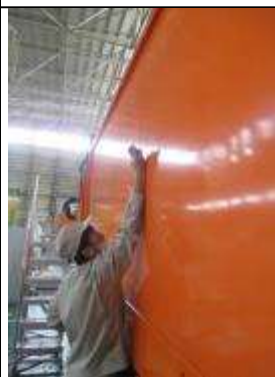
圖 11-7:機械室側 牆總成漆膜測量點 4
