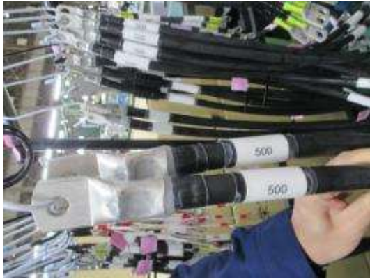
圖28:端子空隙處塗上矽膠
