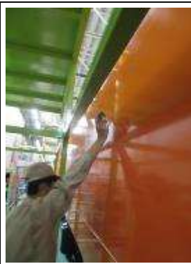
圖 11-3:機械室側 牆總成漆膜測量點 2
