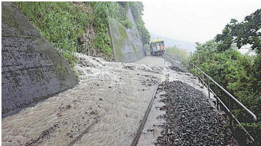
圖 3.4-2 土佐黑潮鐵道列車脫軌事故現場
