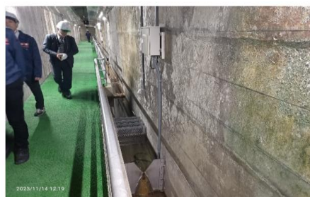
壩體漏水量監測。
