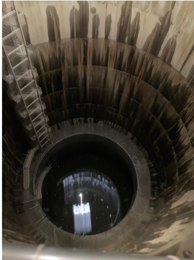
圖36 深度約70m、內徑約30m 的豎井
