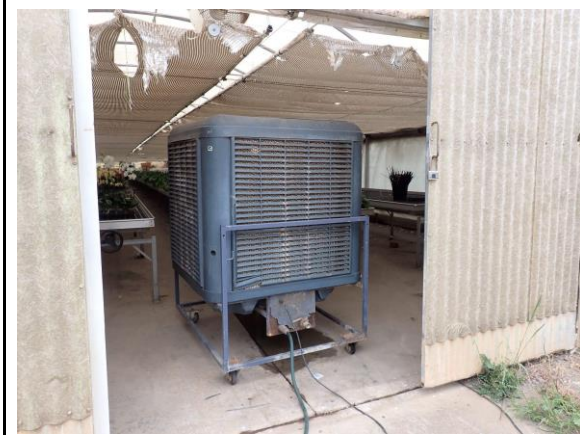
溫室無風扇水牆，故以外加設備之形式補足生產條件。
