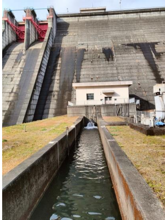
圖 2 農田灌溉用渠道
