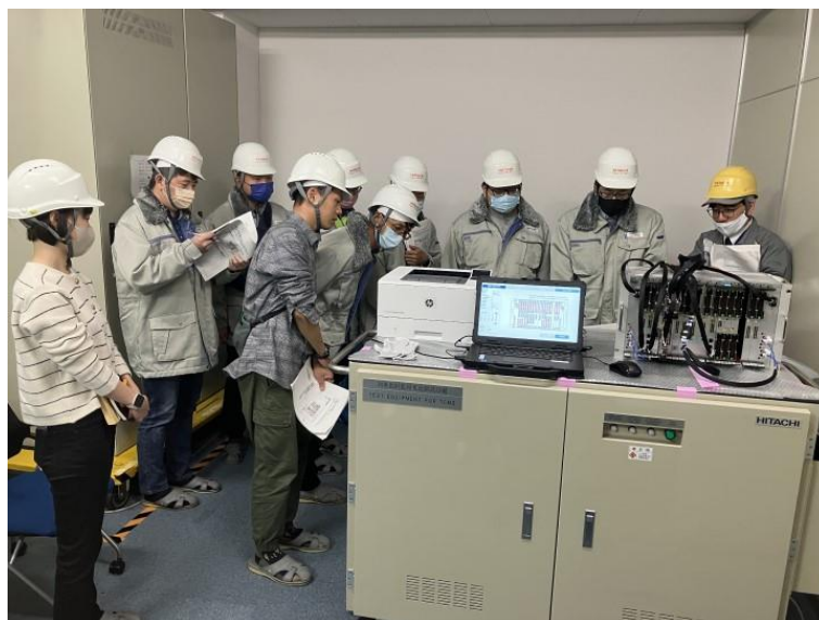
圖 20 TCMS 測試機背面測試纜線連接說明
