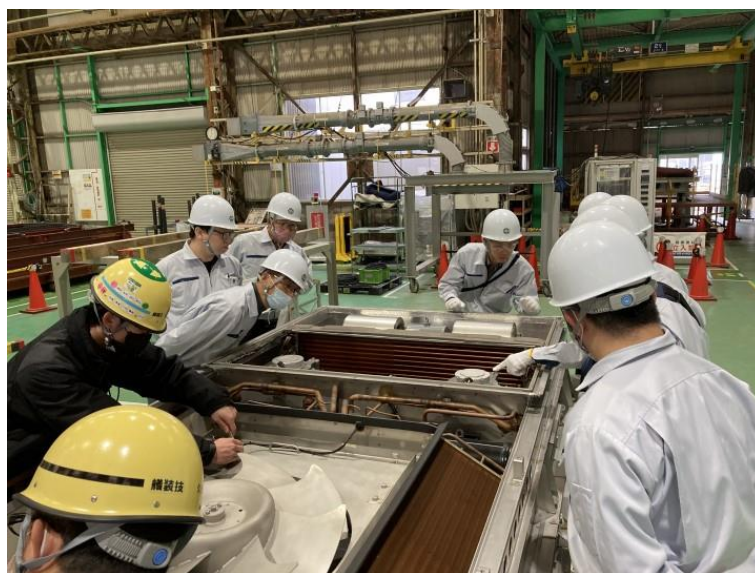
圖 7 空調機各部件實機確認
