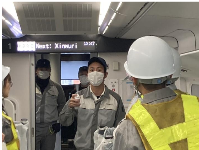
圖 3 火災預警煙霧偵測器測試
