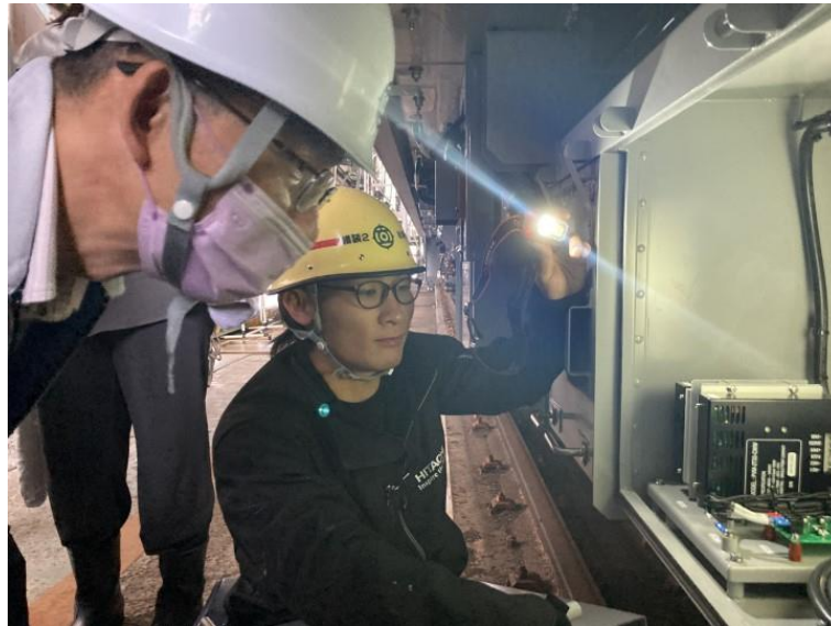
圖 2 直流成份控制箱檢查
