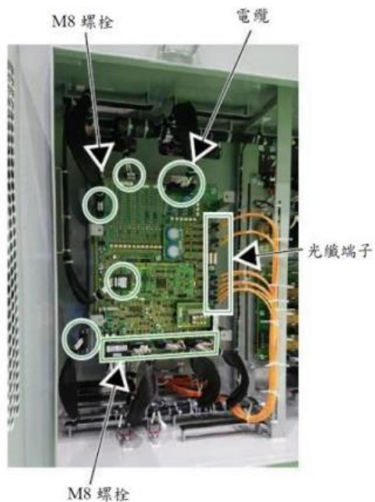
圖 47 移除電纜、螺栓、光纖端子
