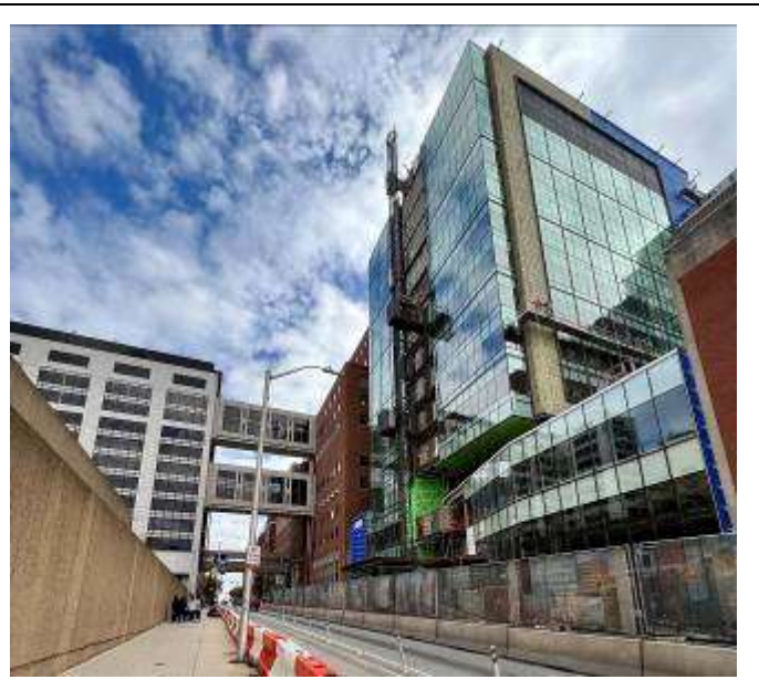
心血管中心旁正在興建中的醫療大樓
