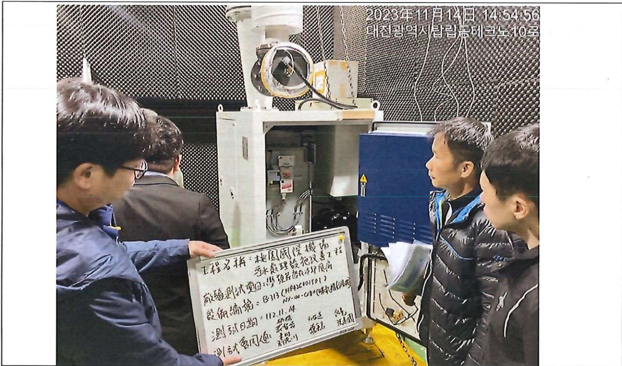
查驗每台變頻器應附有冷卻風扇或其他冷卻方式
