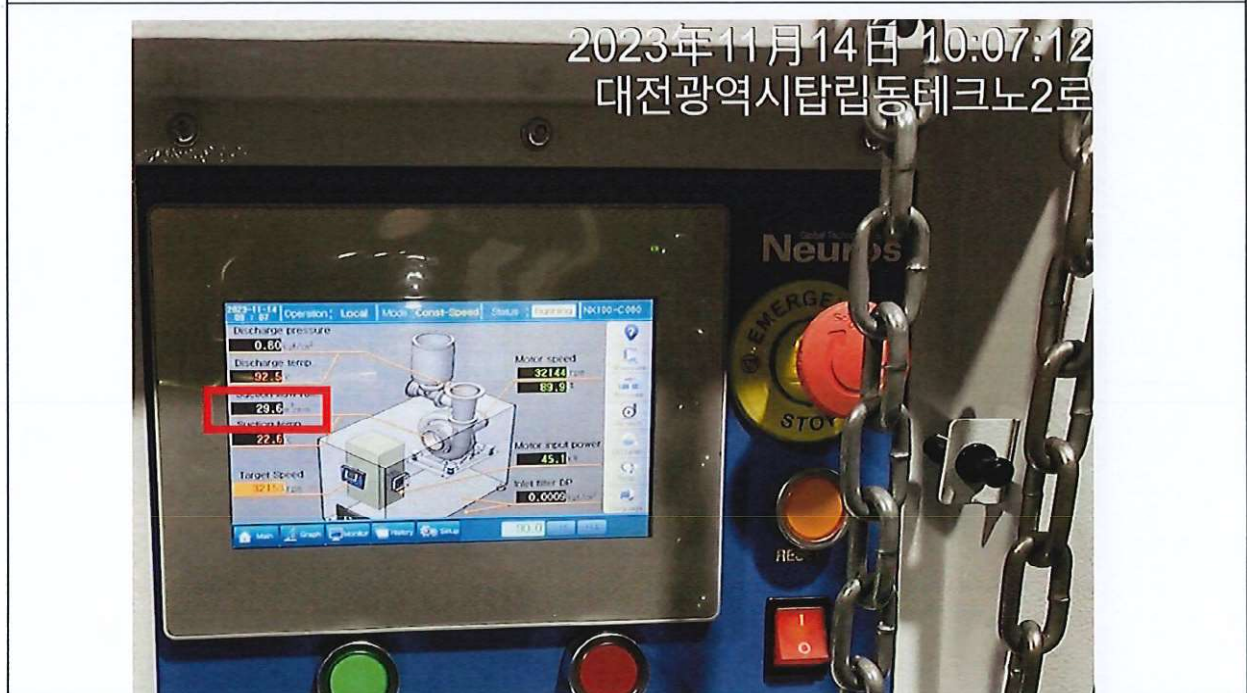
運轉測試出口壓力 8000mmaq 風量 29.6m 3 /min(註:比 30 m 3 /min 更為嚴格)測試運轉期正常運行,無過載及抖動,不發生激變
