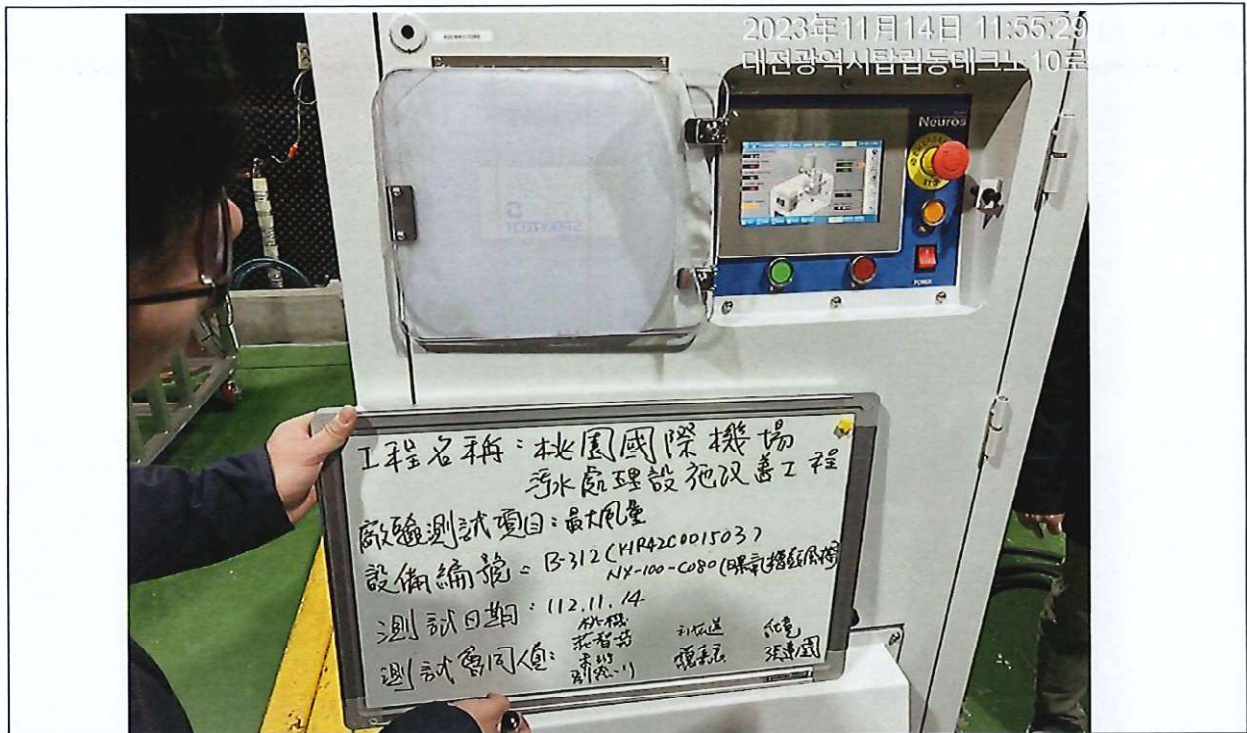
量測最大風量 符合規定
