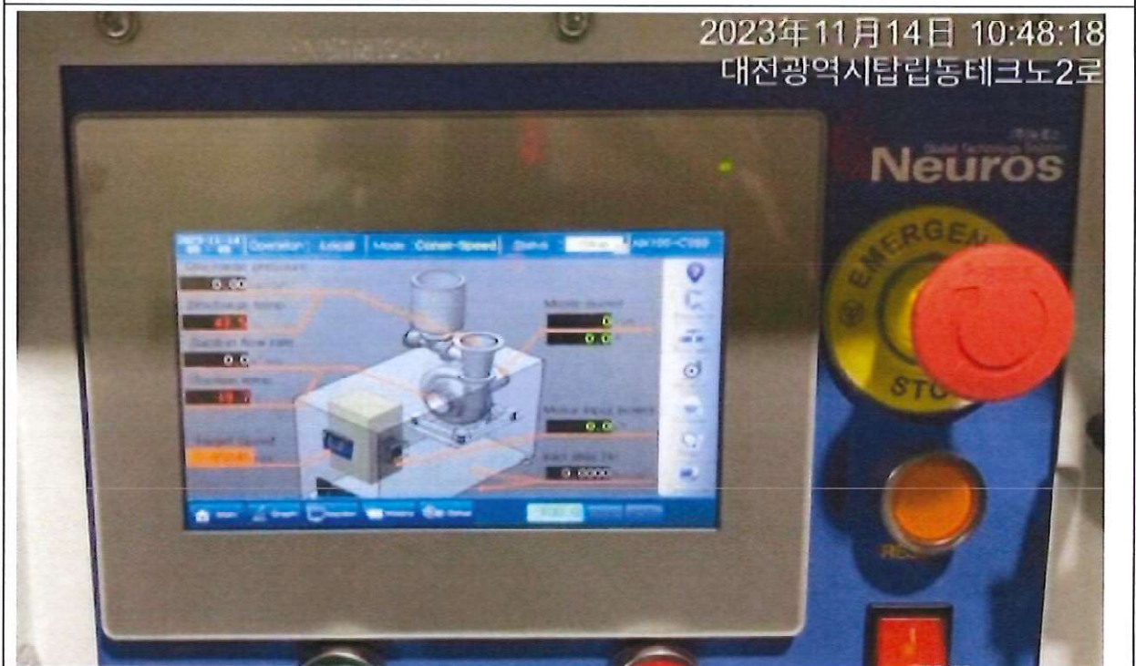
測試壓力大於設定值(1kgf/cm 2 )出現警告頁面後隨即自動停止運轉 符合規定 本測試為動態畫面詳光碟 B311 壓力大於設定值自動停機
