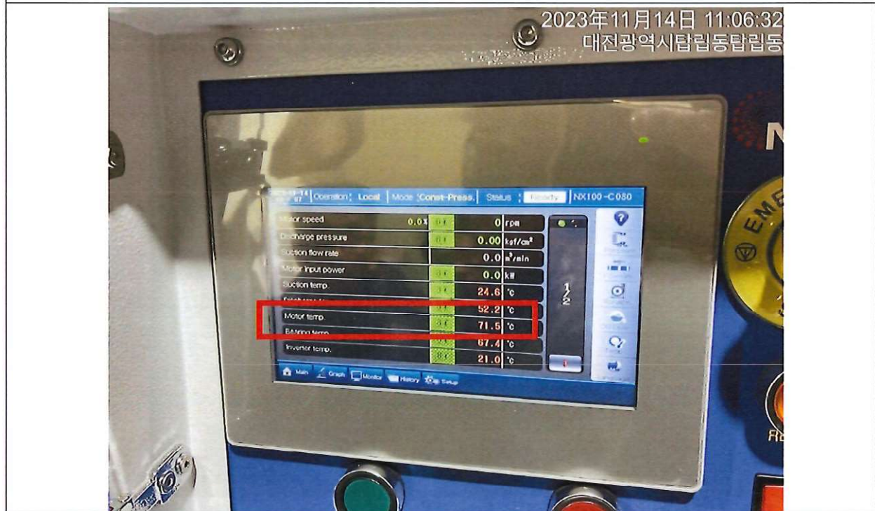
經查馬達溫度顯示於單元控制，(傳訊至中控室部份待系統測試完成後查驗) 符合規定
