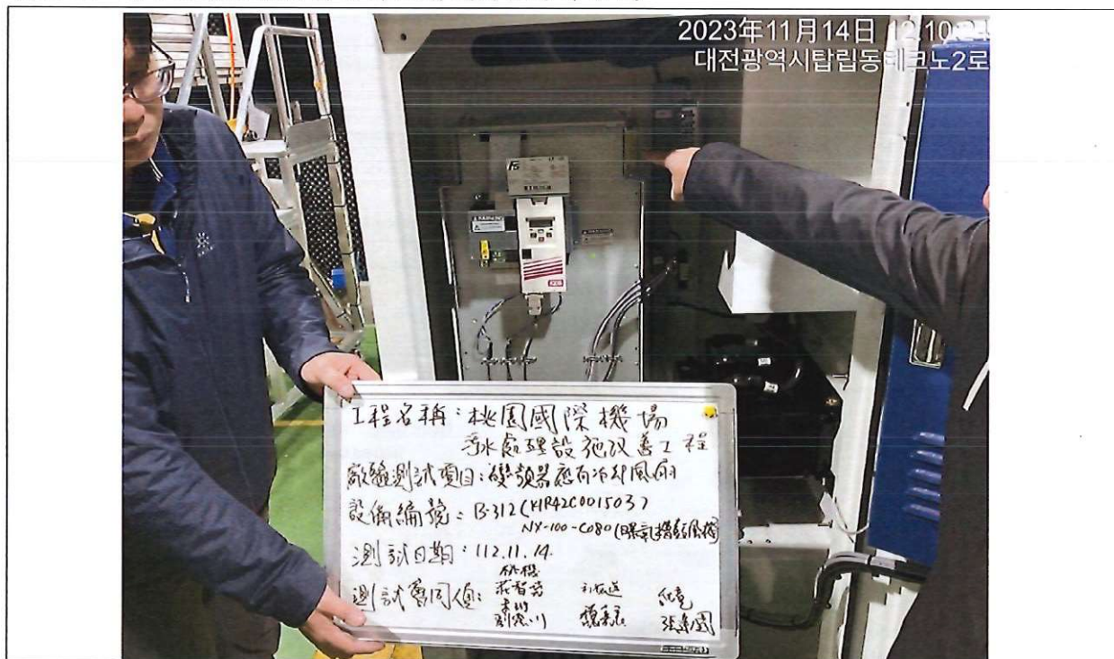
查驗每台變頻器應附有冷卻風扇或其他冷卻方式
