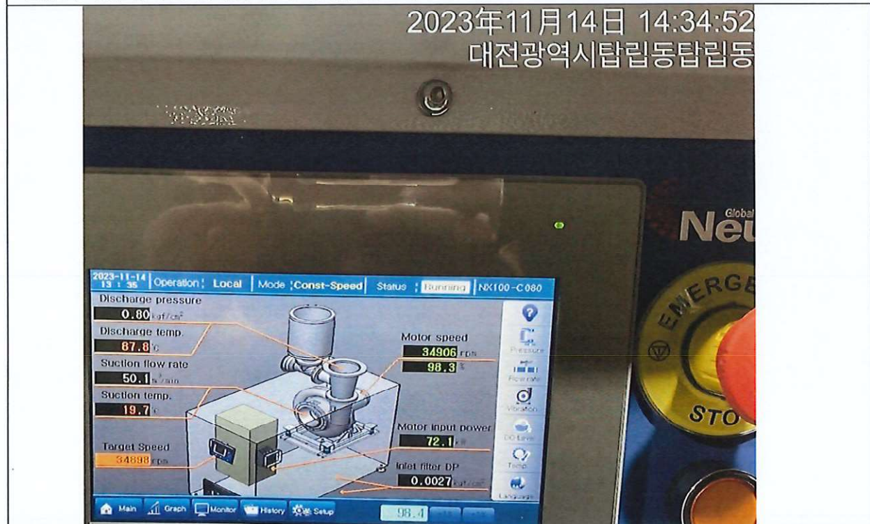
運轉測試額定風壓及風量時轉速為 34906rpm 符合規定
