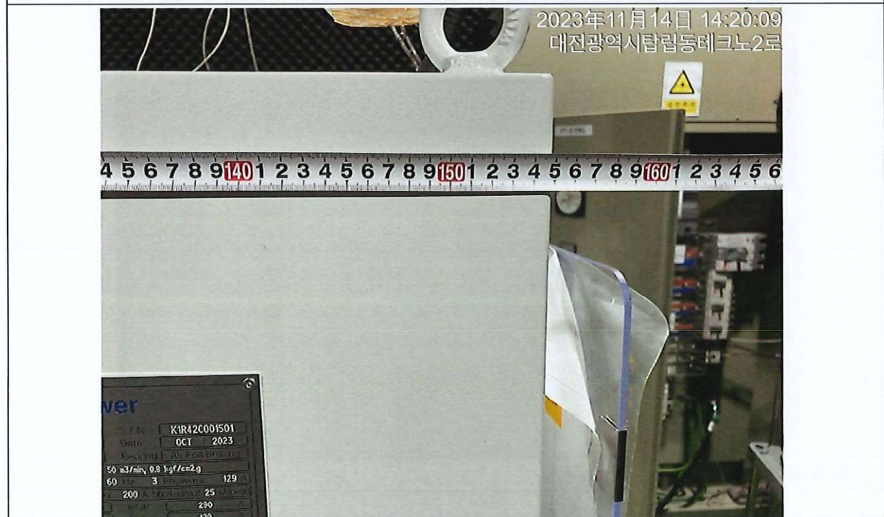
查驗設備尺寸 D(1548 mm) 符合規定
