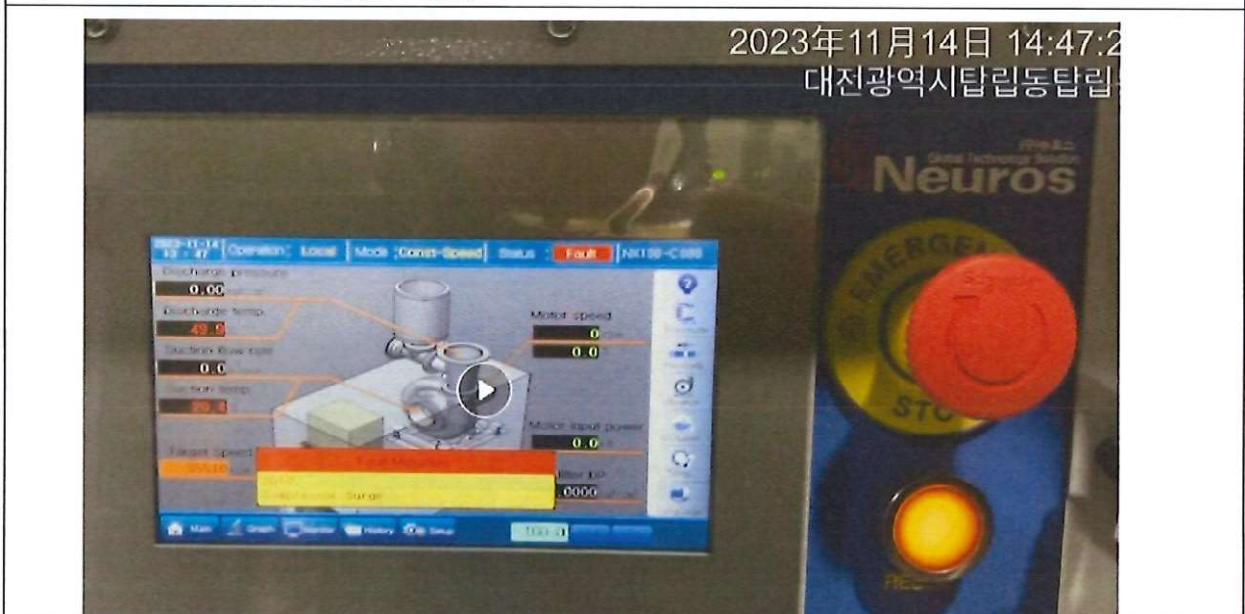
測試壓力大於設定值(1kgf/cm 2 )出現警告頁面後隨即自動停止運轉 符合規定 本測試為動態畫面詳光碟 B313 壓力大於設定值自動停機
