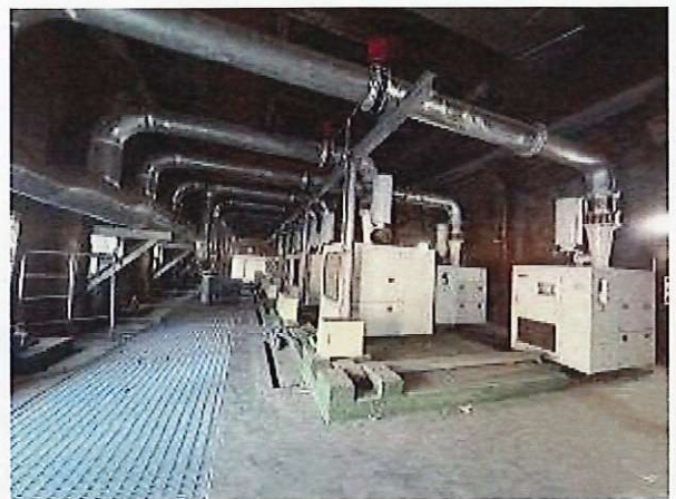
圖片說明:實績廠設備安裝照片
