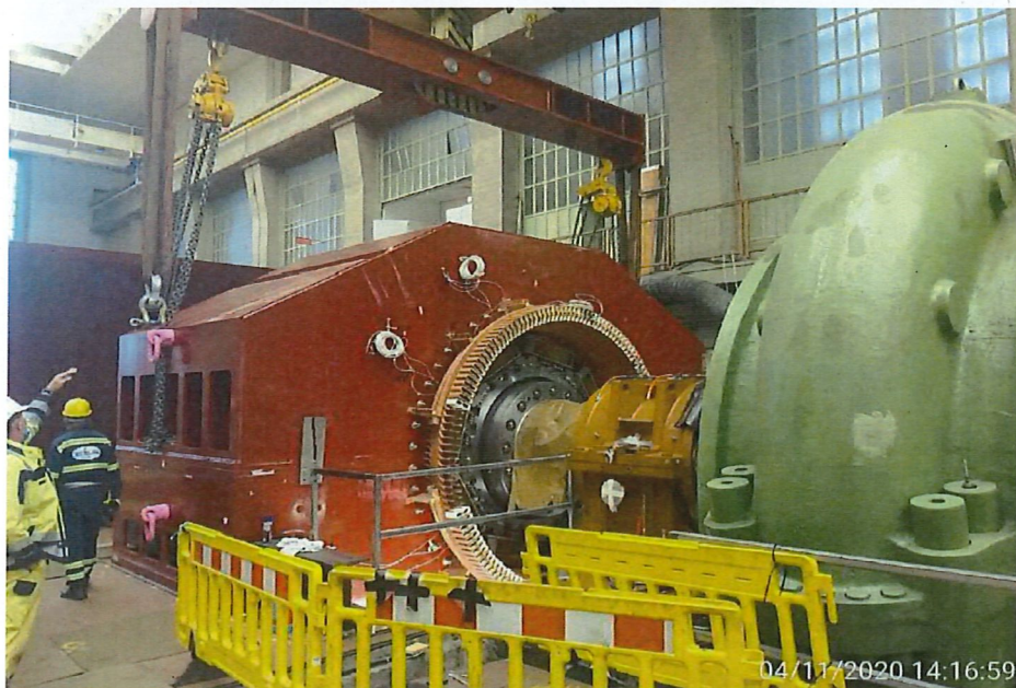
圖 40 Limberg I 機組施工照片
