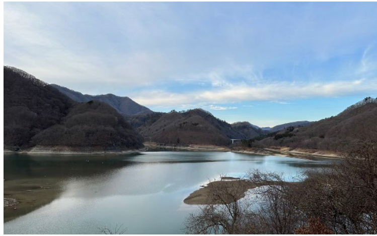
圖 12 五十里崩塌天然堰塞湖現況
