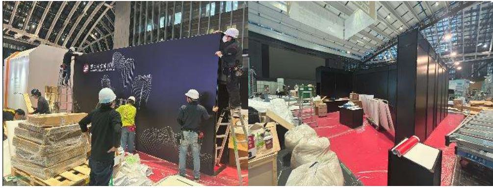
組圖一：佈建中的「臺灣形象展」展會現場及故宮展區(位於新宿區住友大樓三角廣場)
