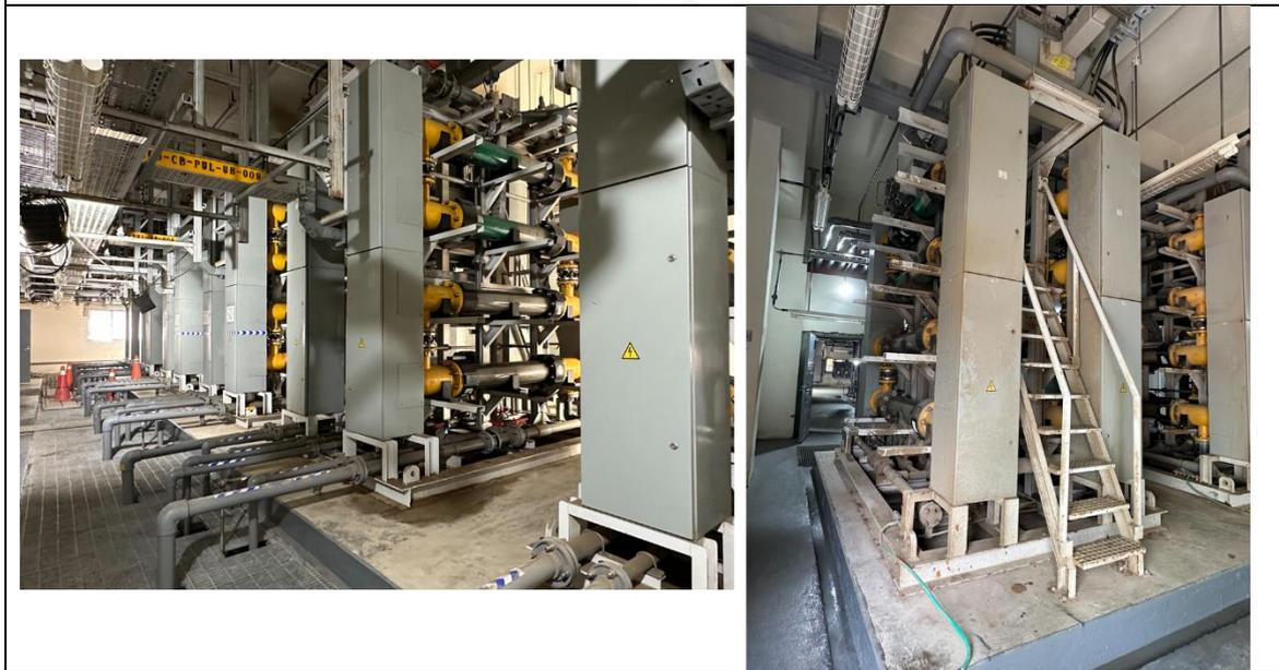
圖 14 板式雙極電解槽示意圖及實廠圖
