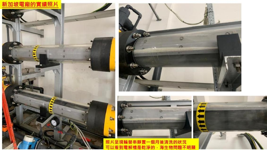
圖 21 設備輪用 2 年後電解槽內仍保持潔淨
