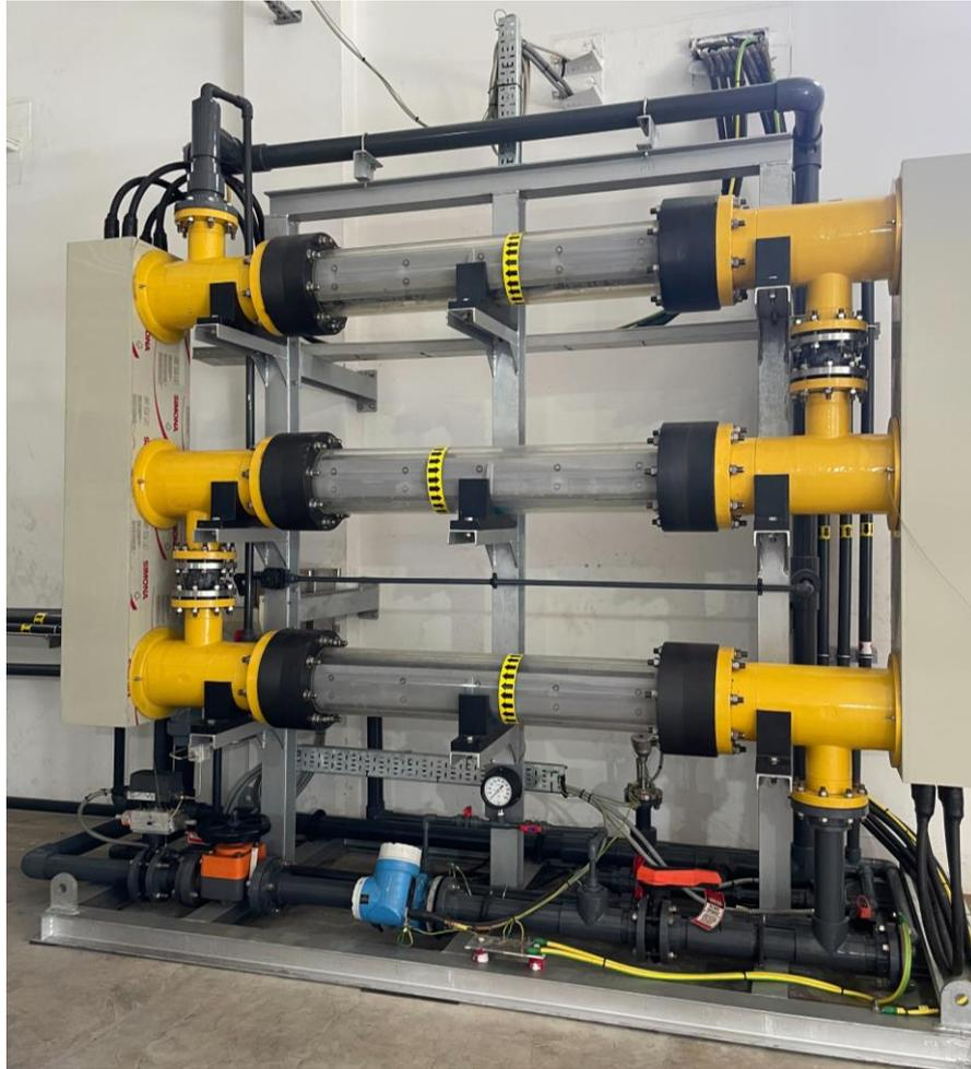
圖 11 板式雙極次氯酸鈉產生器電解槽外觀
