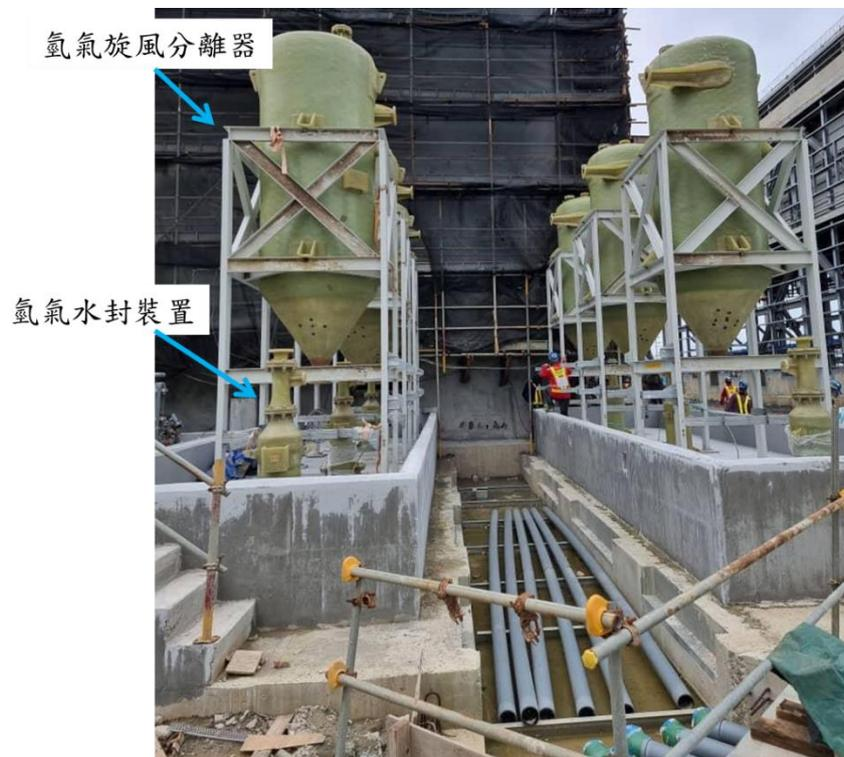
圖 17 旋風脫氫裝置與氫氣水封裝置
