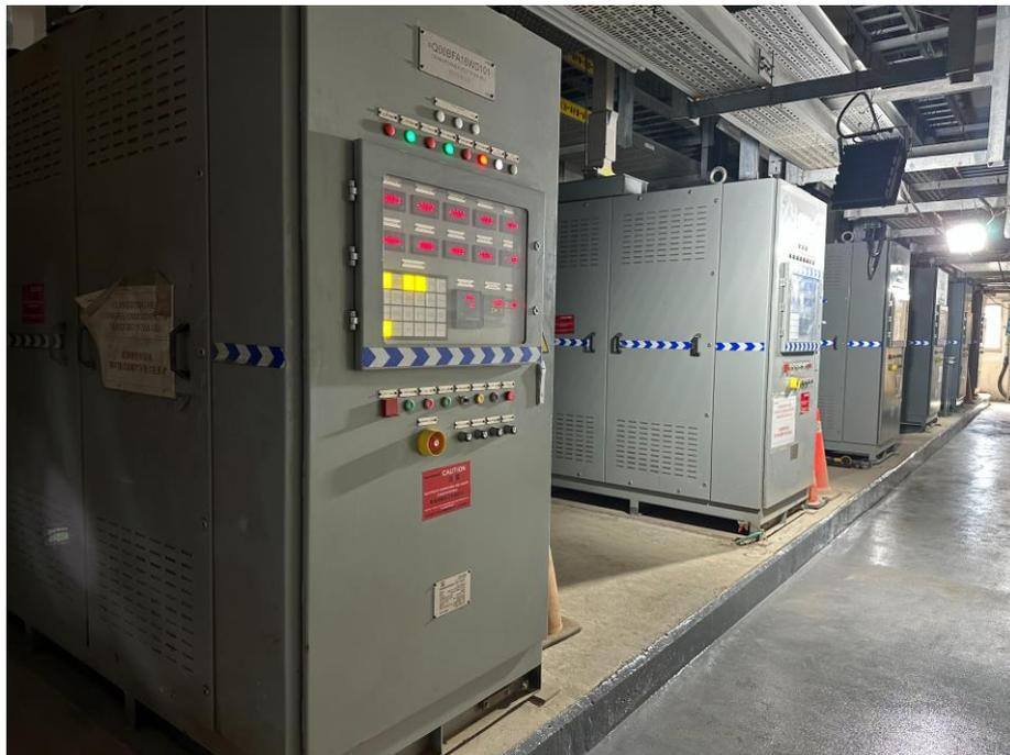
圖 13 變壓器-整流器
