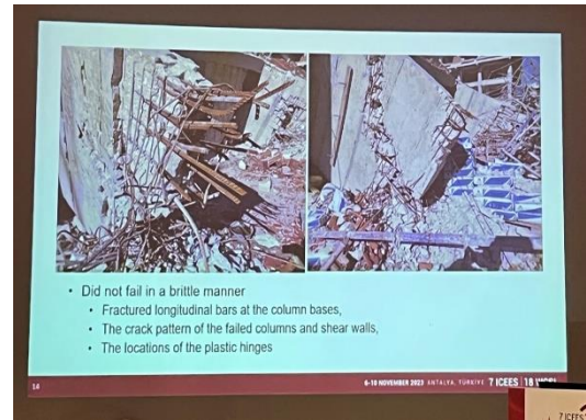
圖23、案例未發生脆性破壞
