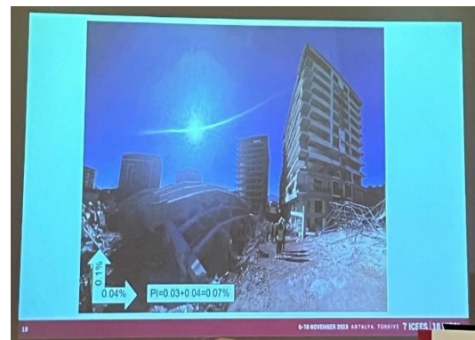
圖27、倒塌案例 PI 值0.07%
