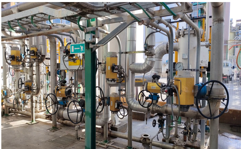
圖二十一 現場控制中心
