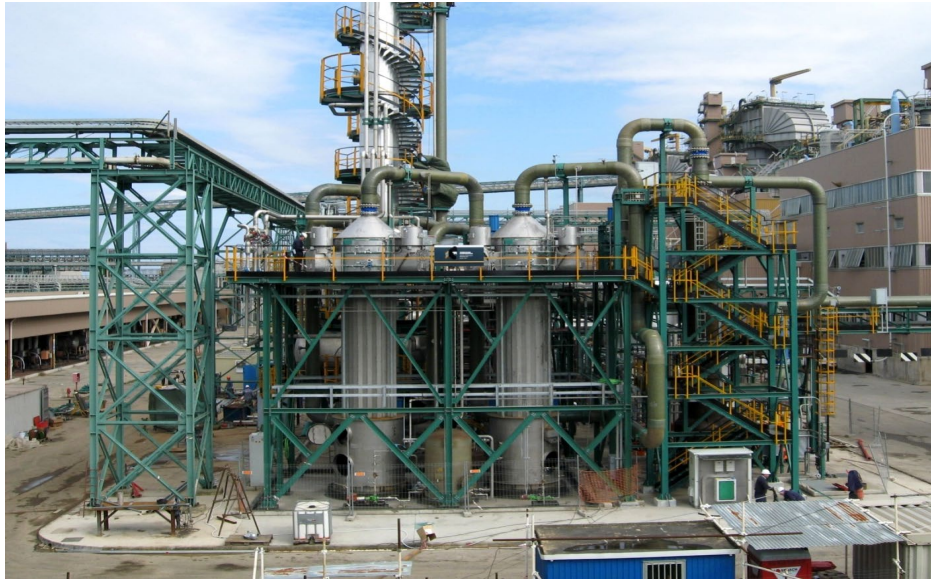
圖十七 濕式靜電集塵系統
