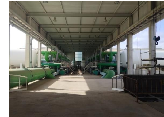
圖 11、海淡廠前處理加藥設備
