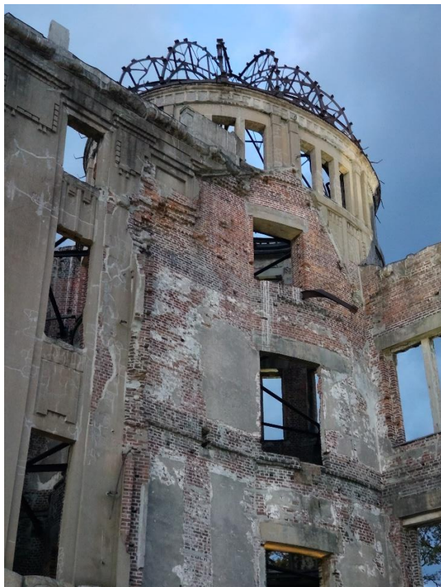
原爆圓頂館，可見其部分磚造部分鋼筋混凝土構造
