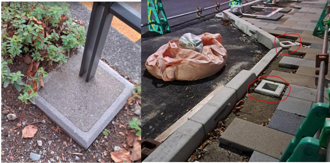
預鑄中空基座，桿柱放入後再灌漿，基礎整齊有導角且不會有螺栓突出
