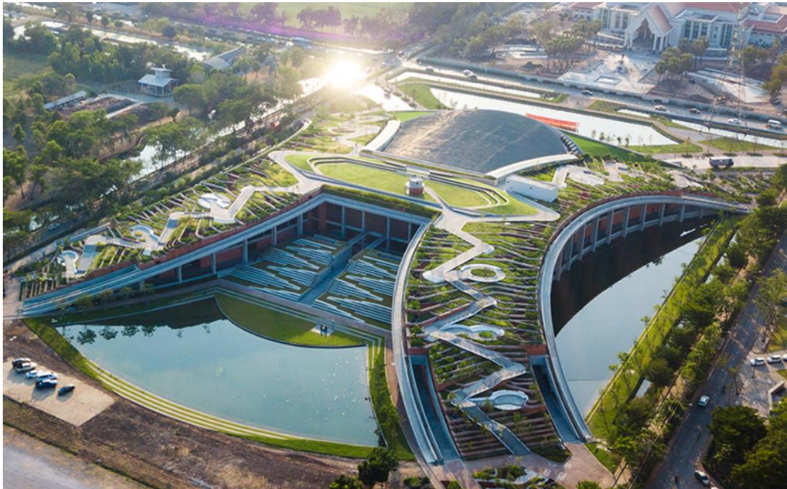
圖 14.法政大學屋頂模仿了水梯田收集雨水減緩徑流
