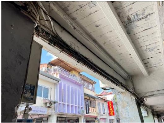
圖 113、建築梁柱使用耐用的婆羅洲鐵木。
