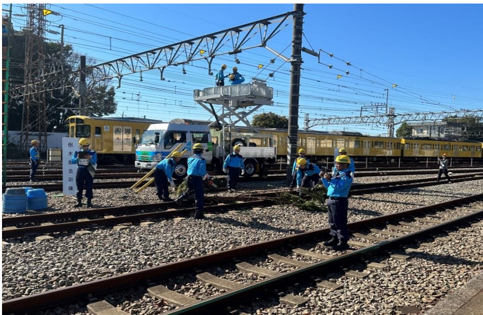
圖 12-軌路兩用車駛入路線並以升降斗進行電車線搶修
