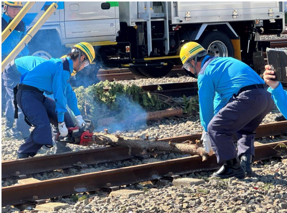
圖 15-使用電鋸分段鋸開倒樹
