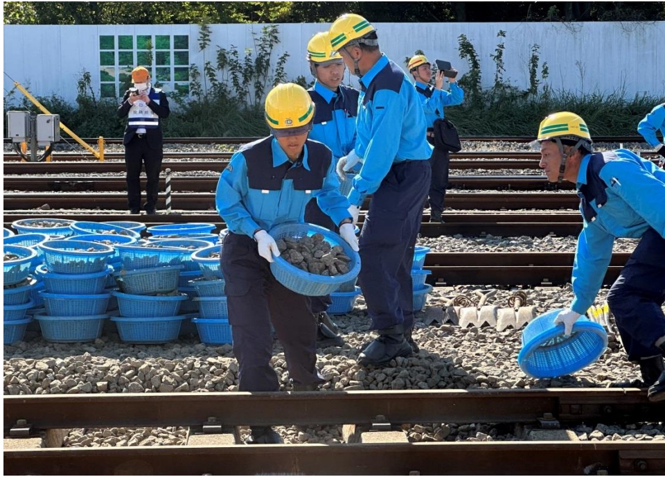
圖 14-搶修人員接力補碴
