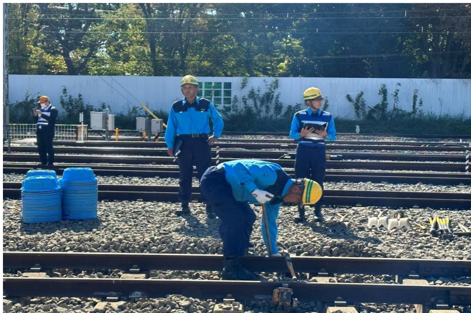
圖 17-砸道後以專用儀器量測軌距及兩條鐵軌水平
