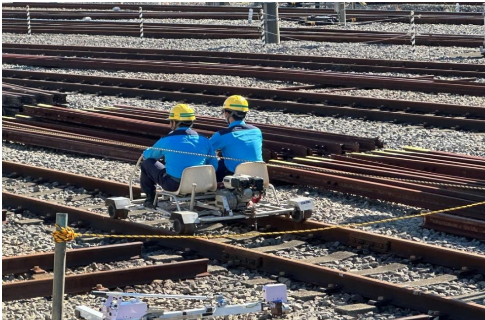
圖 13-搶修人員駕駛機器腳踏車快速前往現場進行搶修
