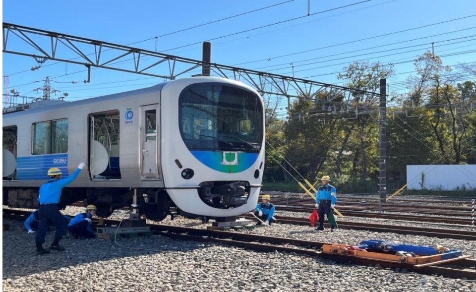
圖 18-使用油壓千斤頂(NDF)將出軌車輛頂起
