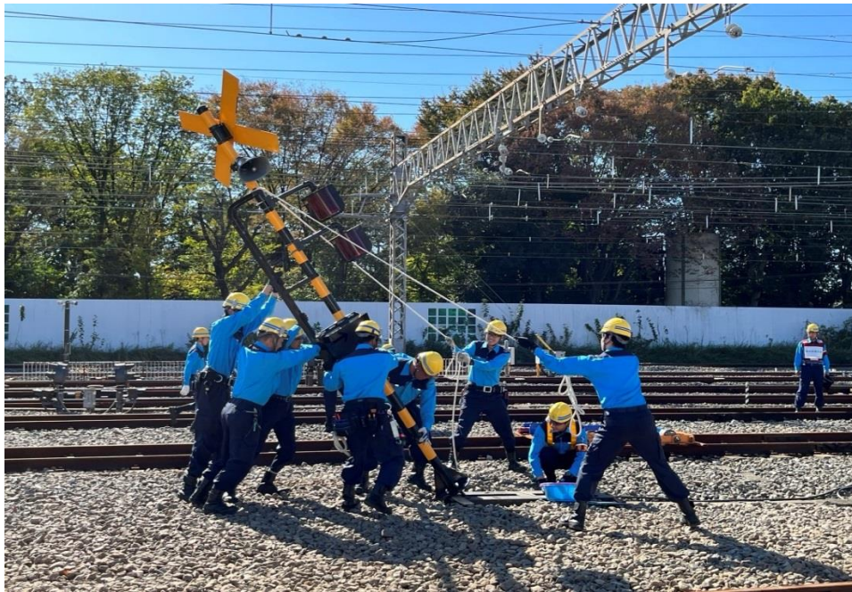
圖 11-搶修倒塌的平交道告警設備
