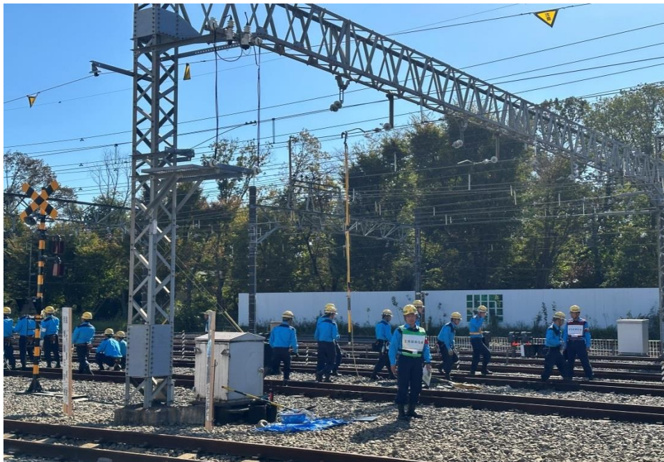
圖 9-電車線接地完成
