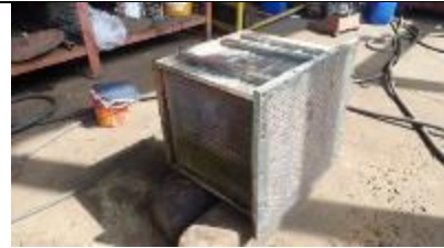
電機空氣冷卻器化學清洗
