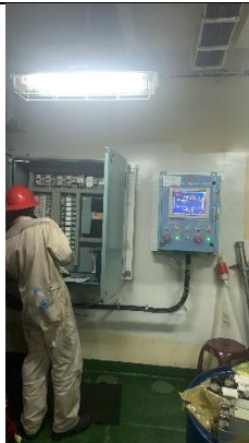
查修壓艙水處理系統
