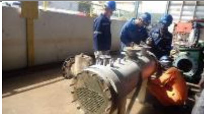
大氣冷凝器清潔試壓
