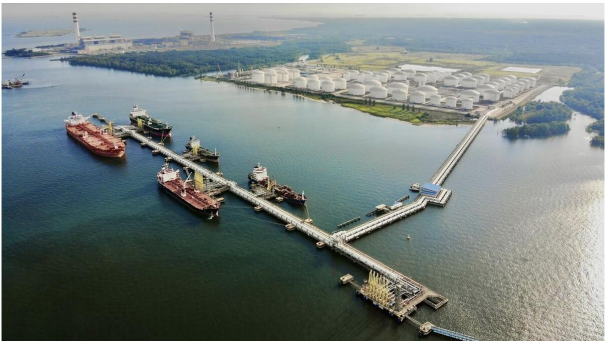
圖三、ATB — Malaysia 的俯視圖(via VTTI)
