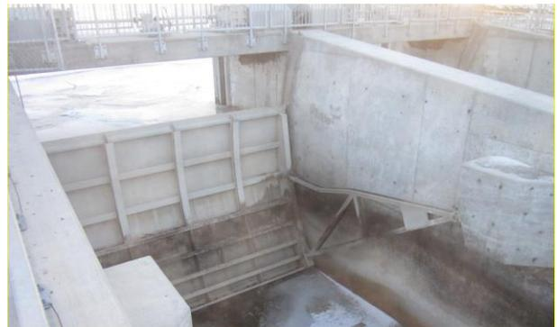
圖 41、弧型閘門桁臂受力變形
