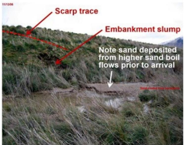
圖 95、壩體下游坡面及壩趾下游破壞情形
