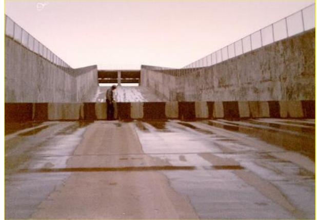
圖 43、McPhee 壩溢洪道增設起跳補氣設施
