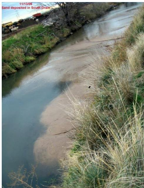
圖 94、南側排水混濁及土砂攜出
