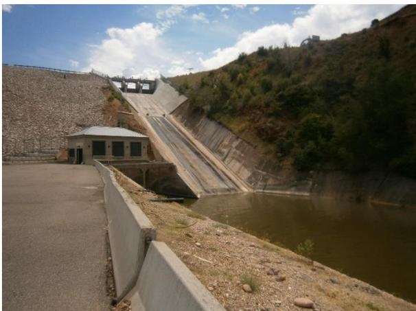
圖 86、溢洪道洩槽堰面及側牆滲水
