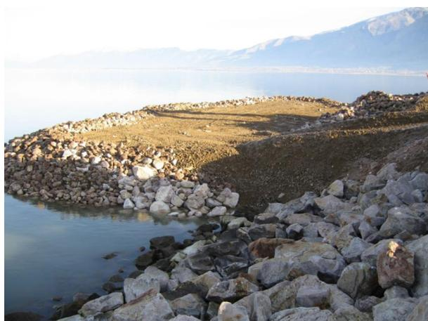
圖 99、壩體上游側破口封堵作業
