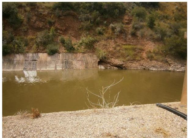
圖 87、下游河道邊坡坡面工滲水及掏刷
