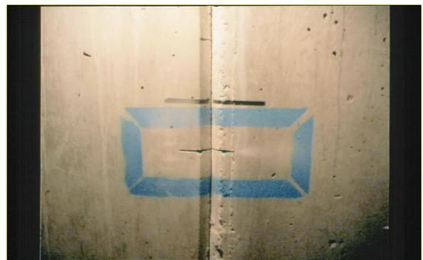
圖 13、接縫處採噴漆或畫線方式監測位移
