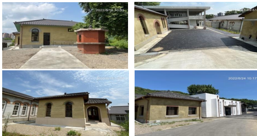
圖 3：修繕後十二棟附屬建築群
