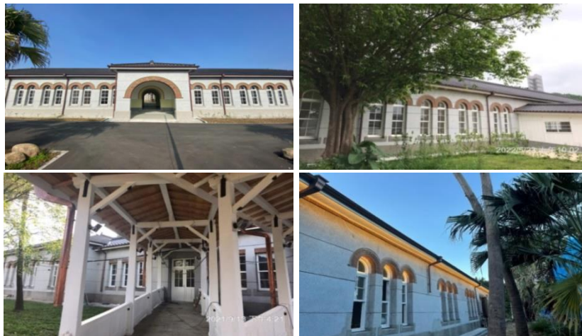
圖 2：修繕後王字型舊醫院
