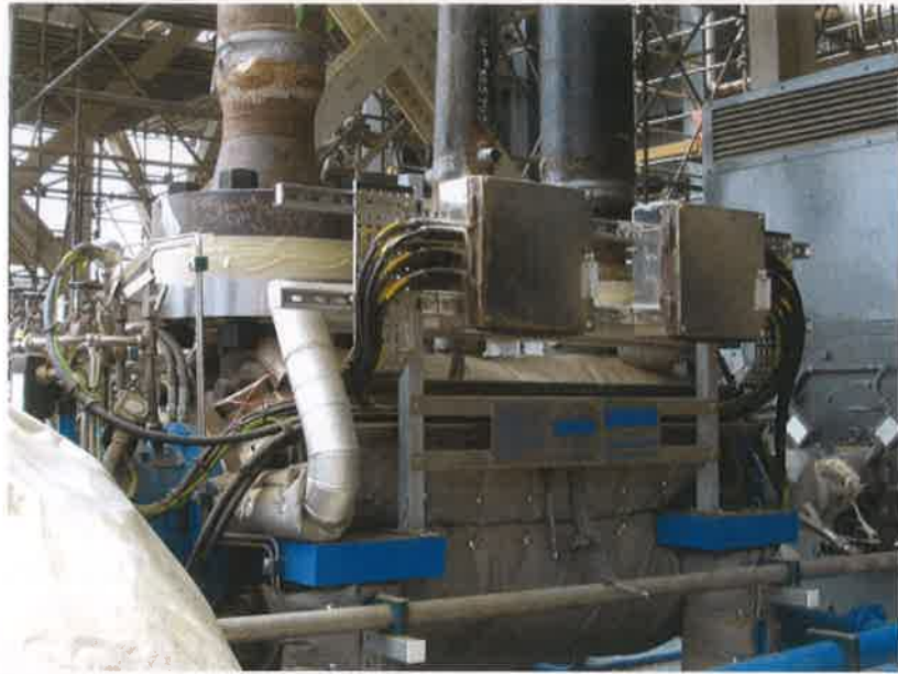
圖二十八、鍋爐飼水泵安裝
