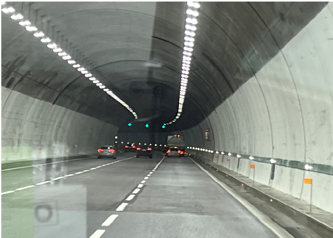
圖 17 高速公路隧道內照明及標線
