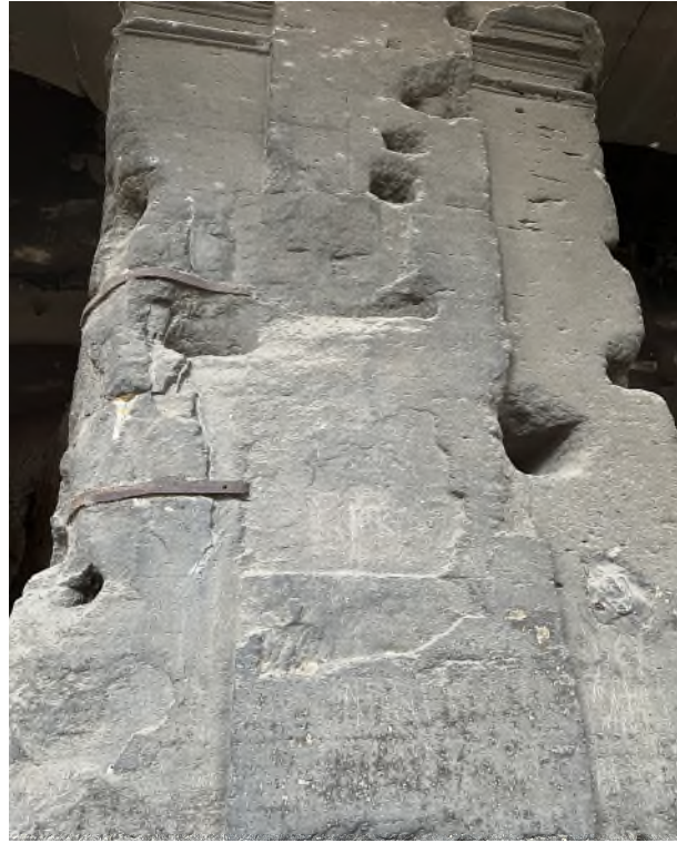
圖 29 立柱石灰岩及固定鐵件
