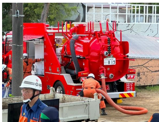
圖 66 機動部隊操作土石抽取車
