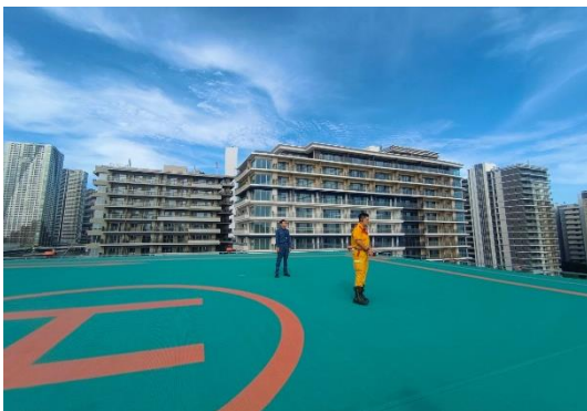
圖 32 臨港消防署頂樓停機坪(局部)
