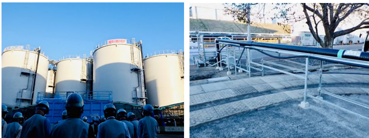
圖 10 K4桶槽區及ALPS處理水輸送管
