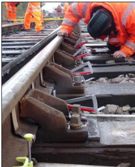
圖 18 軌道動態沉陷計安裝
