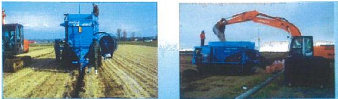
圖4-4 暗渠排水管施工狀況
