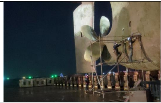
搭架清理海底門及排外管
