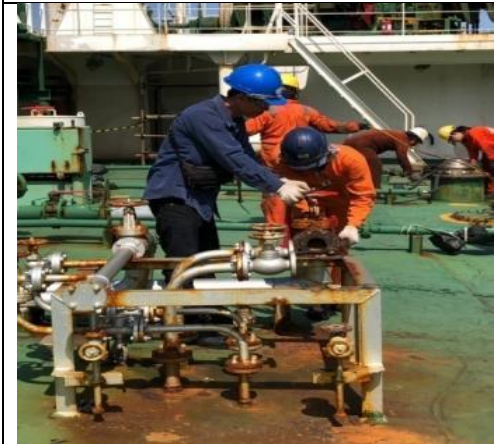
貨艙加熱管 Valve 保養整修
