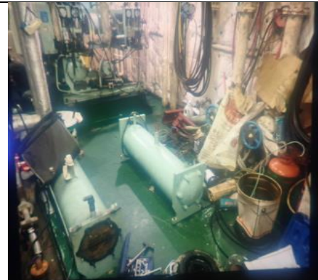
#2冰機冷凝器備品更換
