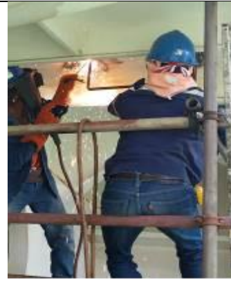
電纜支架重新燒焊
