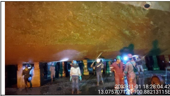
人力剷除底板海生物
