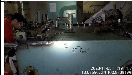
生活污水櫃處理櫃銹蝕整修
