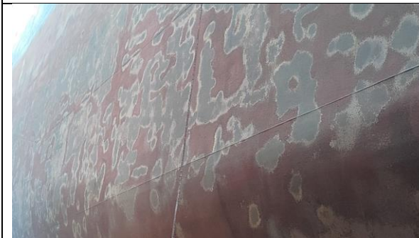
經高壓淡水及 Sa2噴砂表面處理
