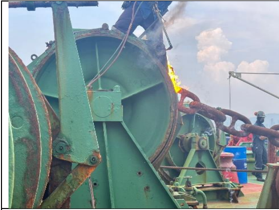
錨機錨鍊煞車更新
