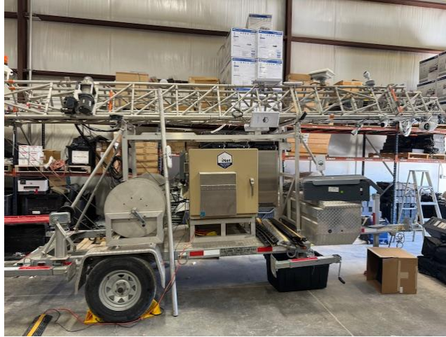
圖 15、移動式 LTE 基站(包含 LTE 基站、網路交換器、供電設備)
