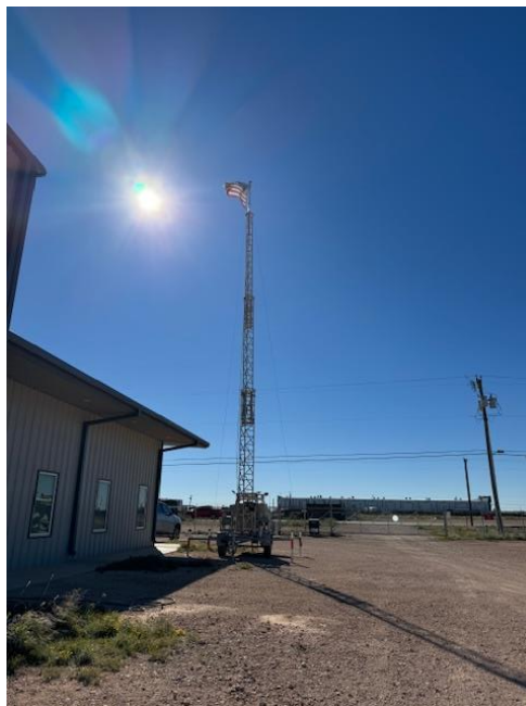
圖 16、架設移動式 LTE 基站之車輛完整樣貌。
