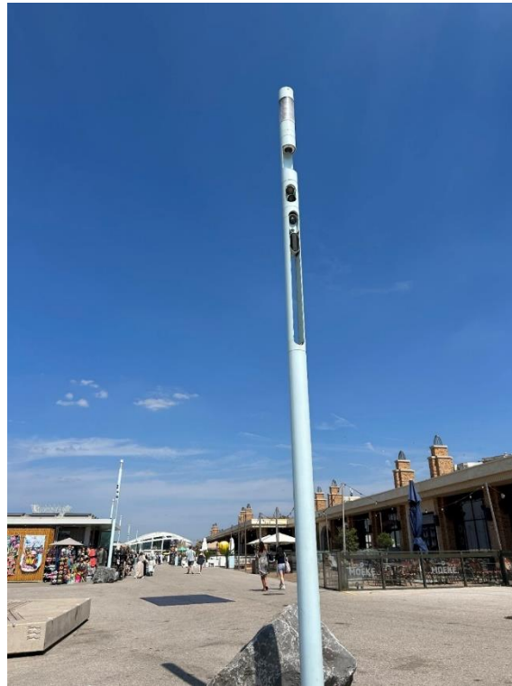
照片 4-1 多功能路燈包含照明、攝影機及噪音監測功能
