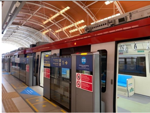
雅加達捷運站內安全閘門
