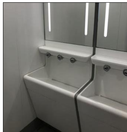
1.2 洗手檯為洗手乳/水龍頭/烘手三合一設計
