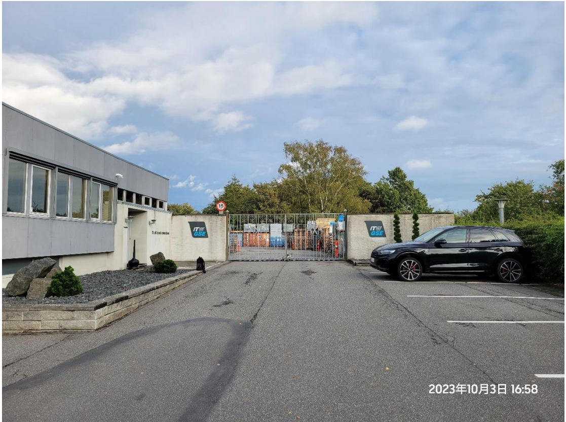
圖 3-4 ITW GSE 公司介紹(一)-工廠大門
