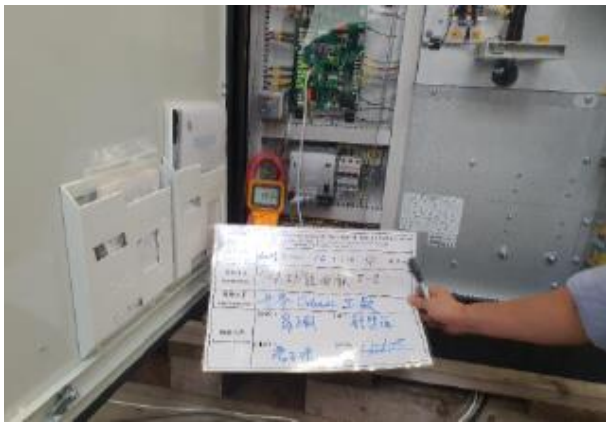
圖 5-36 驗證直流散熱器風扇，及主鼓風機和的功能是否正常。
