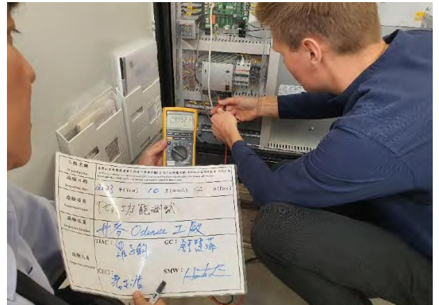
圖 5-29 調整輸出端電壓驗，以證設備功能
