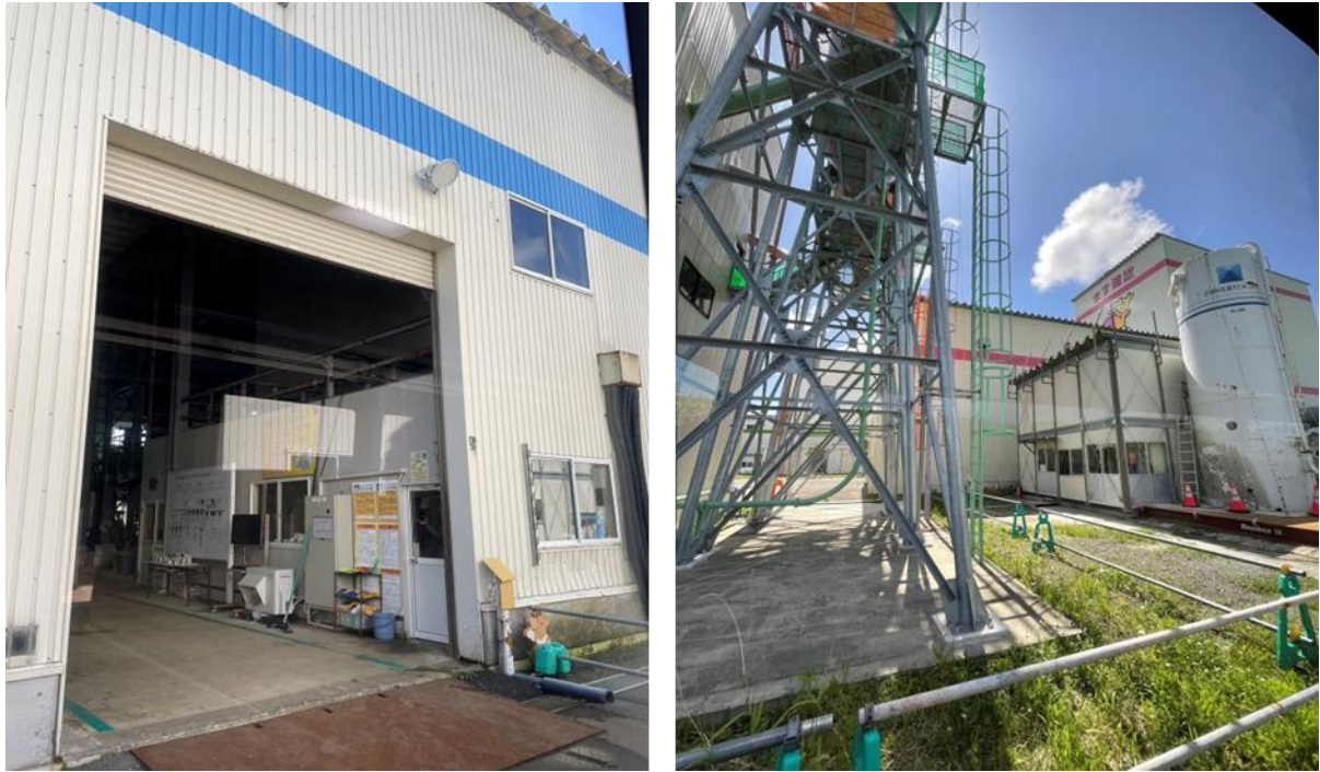
圖 9 地下汙水處理廠房(左圖)及土壤安定技術製備水泥的廠房(右圖)
