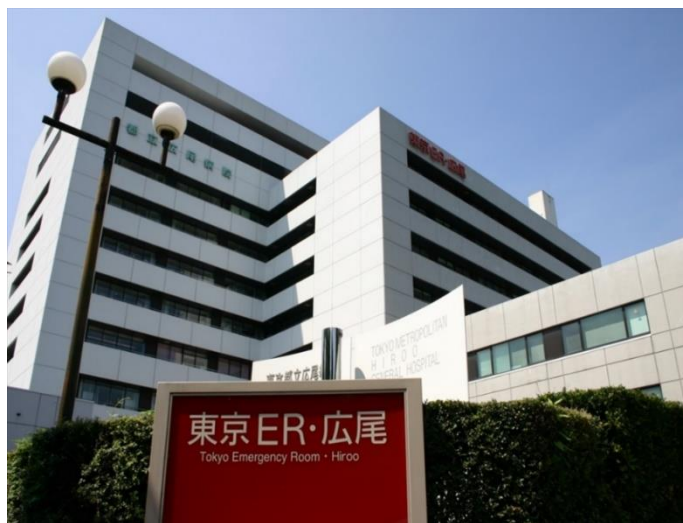
▲ 東京都立廣尾醫院（資料來源：廣尾醫院提供文件）
