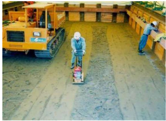
圖 19 處置壕溝覆土層夯實
