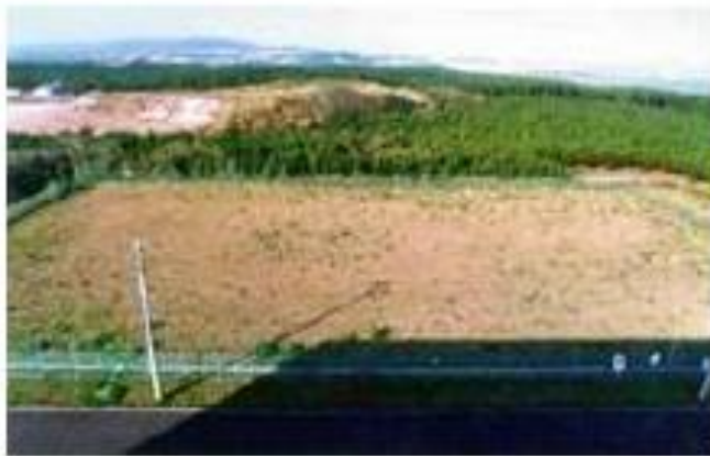
圖 20 處置壕溝完工
