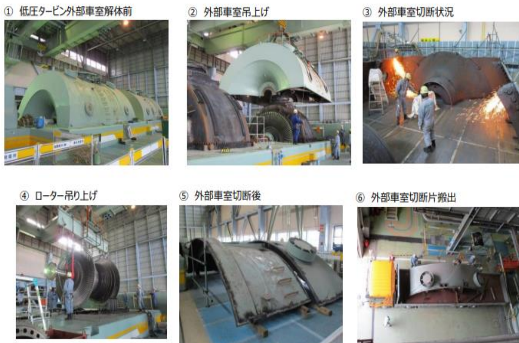
圖 49 美濱核電廠低壓汽機切割情形 (圖片來源 ANDES 訓練資料)
