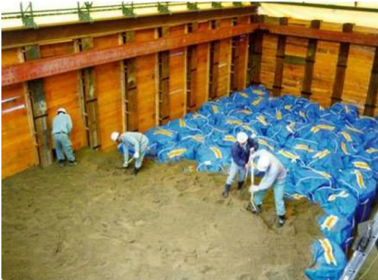
圖 18 處置壕溝放滿太空包廢棄物後於上方覆土
