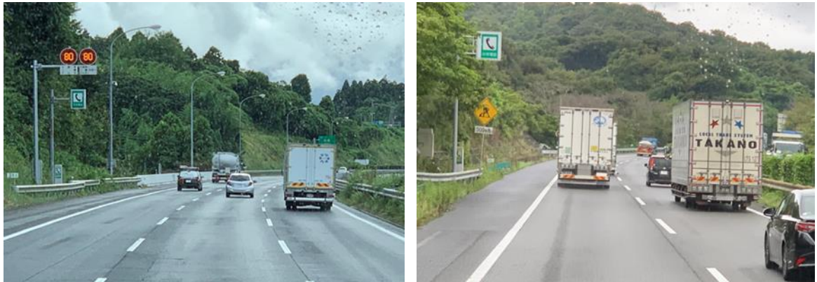
圖3-4-2 速限可變標誌、緊急電話及CCTV
