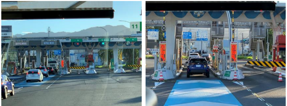
圖3-6-2 ETC車道仍設有柵欄(限速20KPH)
