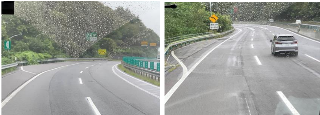
圖3-6-9 日本高速公路路肩寬度不足設有避車彎
