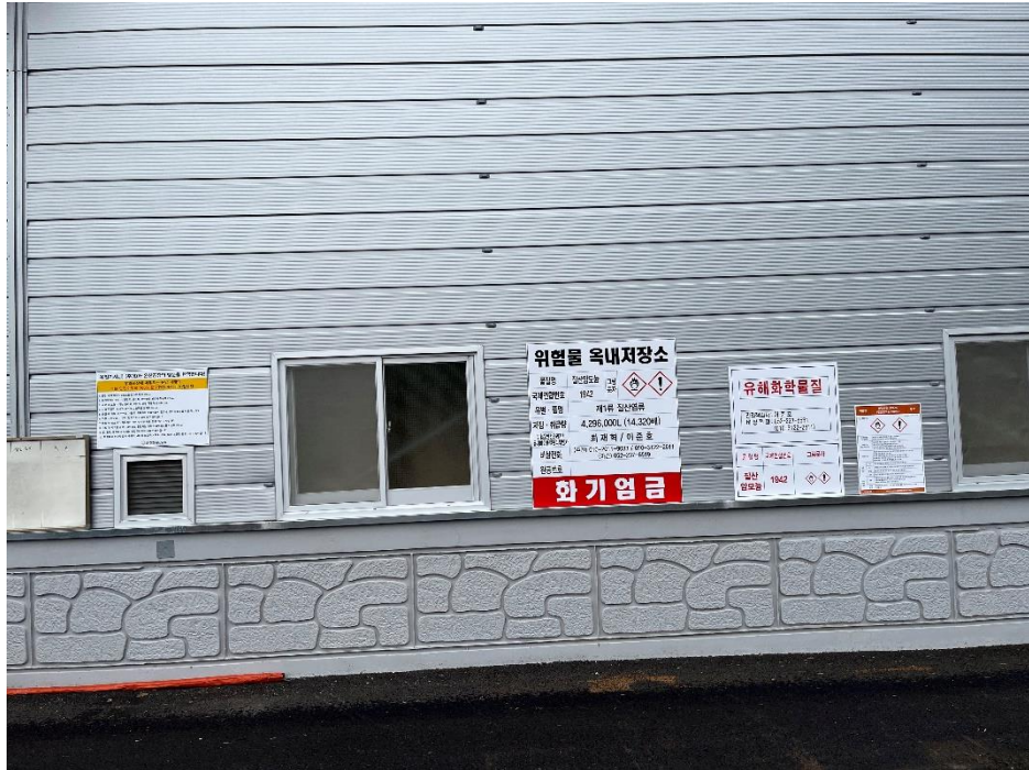
圖 6、庫房外化學物質警示及限存量標示
