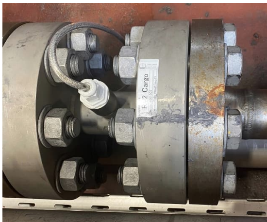
液壓油流量計SENSOR(4001305)
