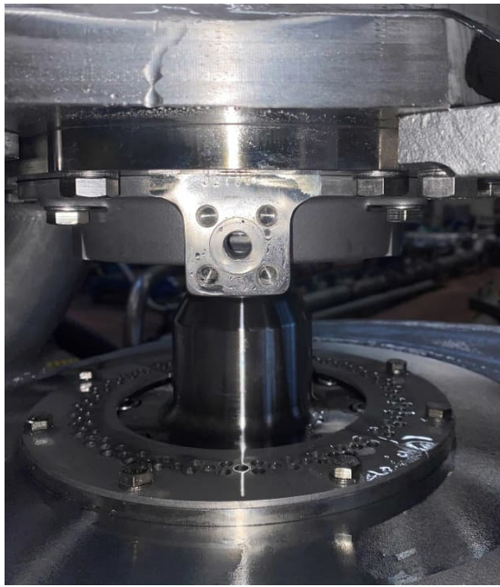
貨油泵測試完成後，確認機械軸封狀況
