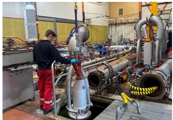
貨油泵組裝(吊入測試水池中)
