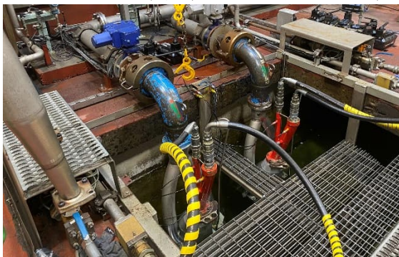
貨油泵組裝完成(安裝於測試水池)
