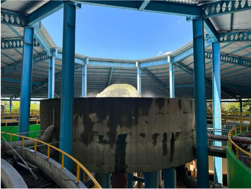
圖 13、Ngagel I 階梯式曝氣設備
