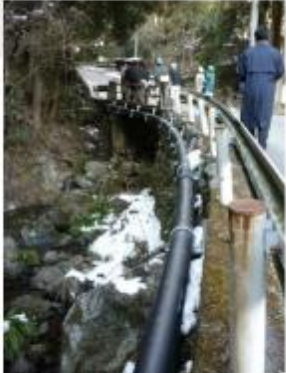
クイック配管(露出配管) (檜原村)
