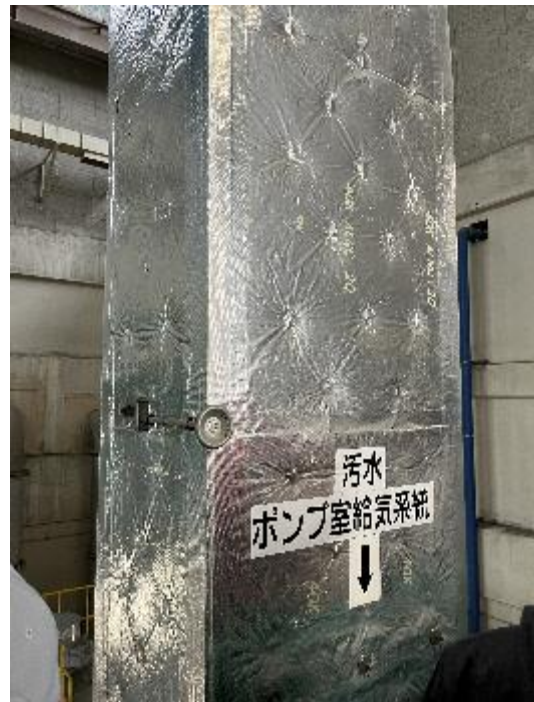
污水泵浦室供氣系統
