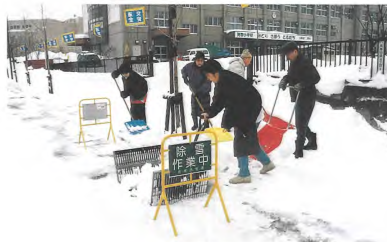
流雪溝投雪状況
