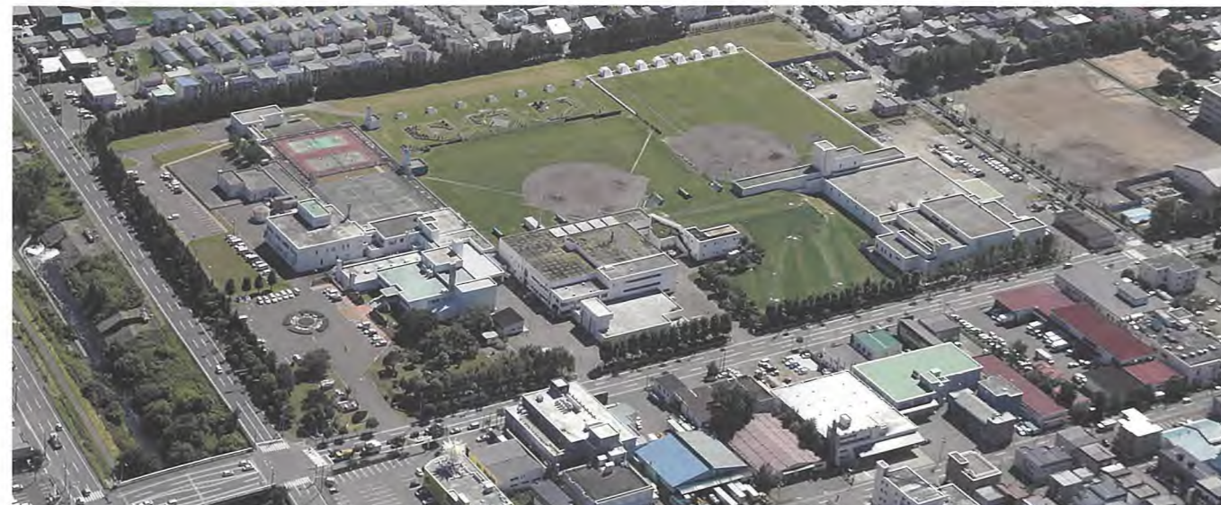
新川水再生プラザ
