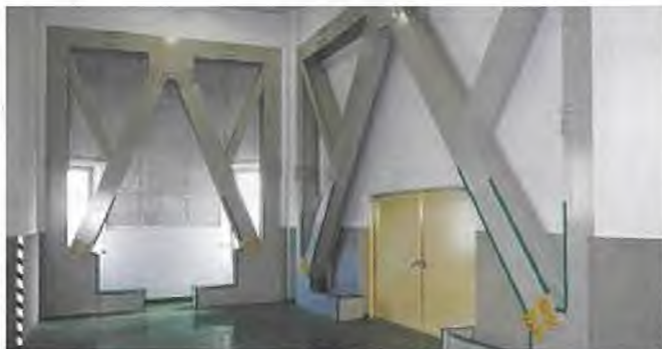
水再生プラザの耐震補強状況
