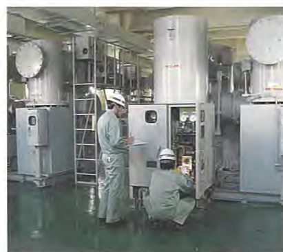
設備の点検・整備
