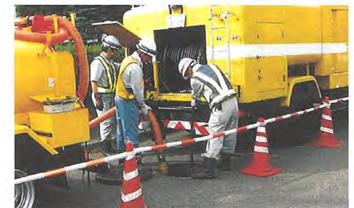
緊急措置訓練（管路清掃）
