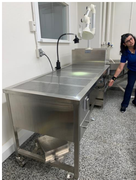
家禽解剖房設置抽風設備與 HEPA 過濾系統
